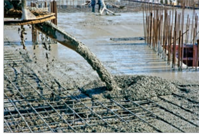
Hormigonado de un forjado.
