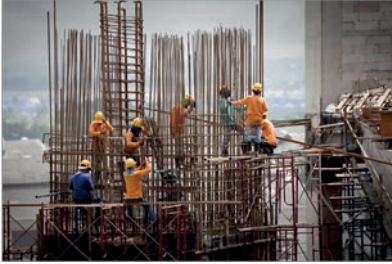
Armaduras internas de las estructuras de hormigón.
