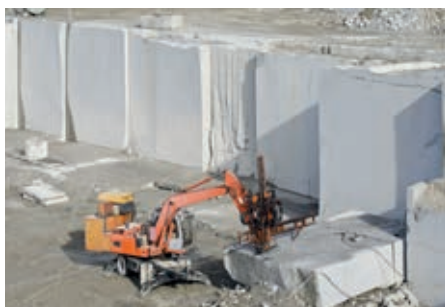
Cantera a cielo abierto.
