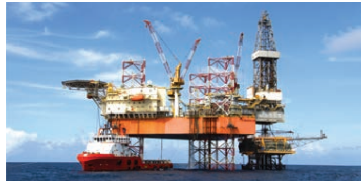
Pozo de perforación en el golfo de Tailandia.
